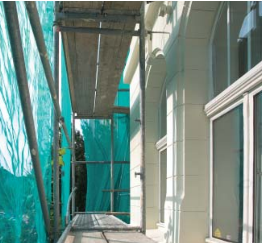
Baumaßnahmen, die Mieter erheblich stören, berechtigen zur Kündigung der Wohnung.
